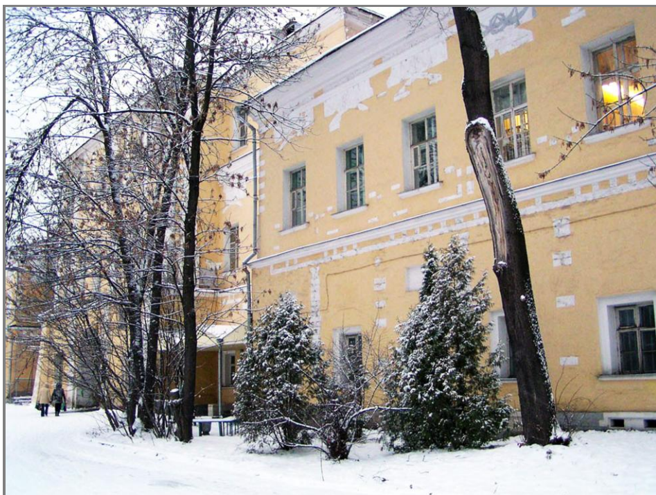
Fig. 3. Fațada estică a palatului Lefortovsk, intrarea în arhivă; sala de studiu se află la etajul 2 (© RGVA) 17 .
